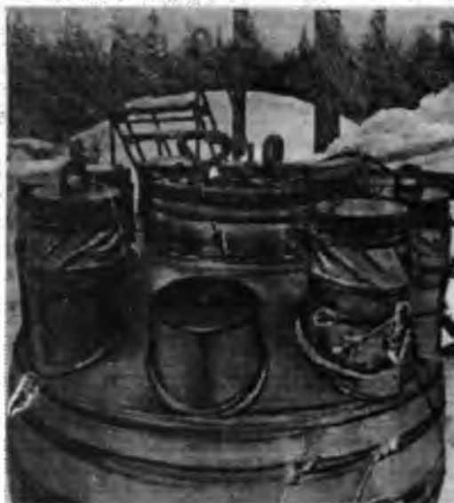
Р и с. 4. То же, что на рис. 3, после опыта № 7 (стрелкой показана трещина возле шва, связывающего горловину с крышей)
