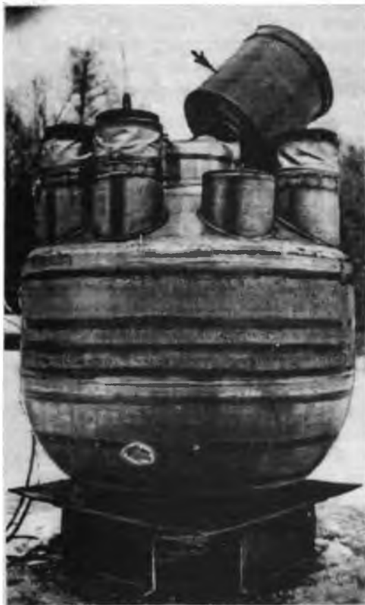
Р и с. 3. Модель II после опыта № 2 (стрелкой показан блок пробок и колонны, выдвинутый из горловины действием взрыва)
